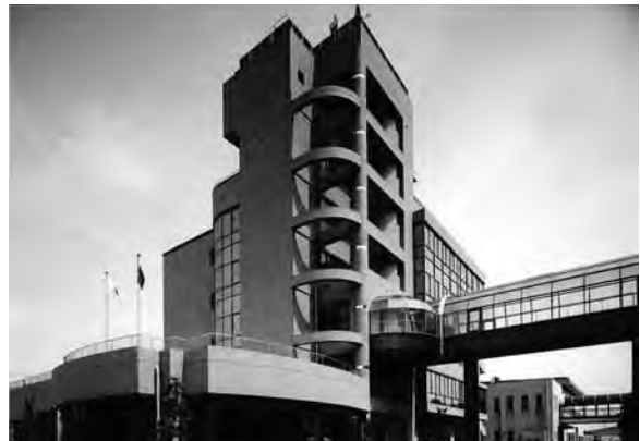
総合実習棟竣工
