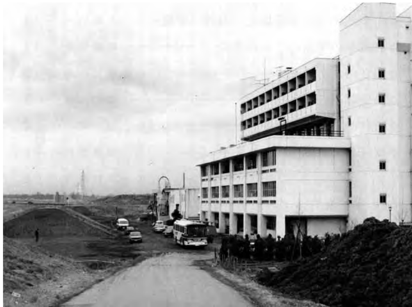
総合実習棟予定地（左側）と本館（S57.3.6） 荒川旧堤防撤去中
