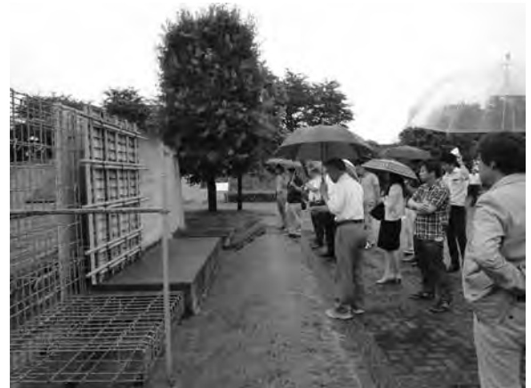
擁壁の配筋について説明を受ける研修生 会計検査院安中研修所
