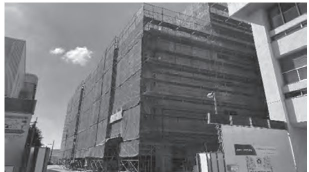
現在の建設状況（R3.9.29撮影）
