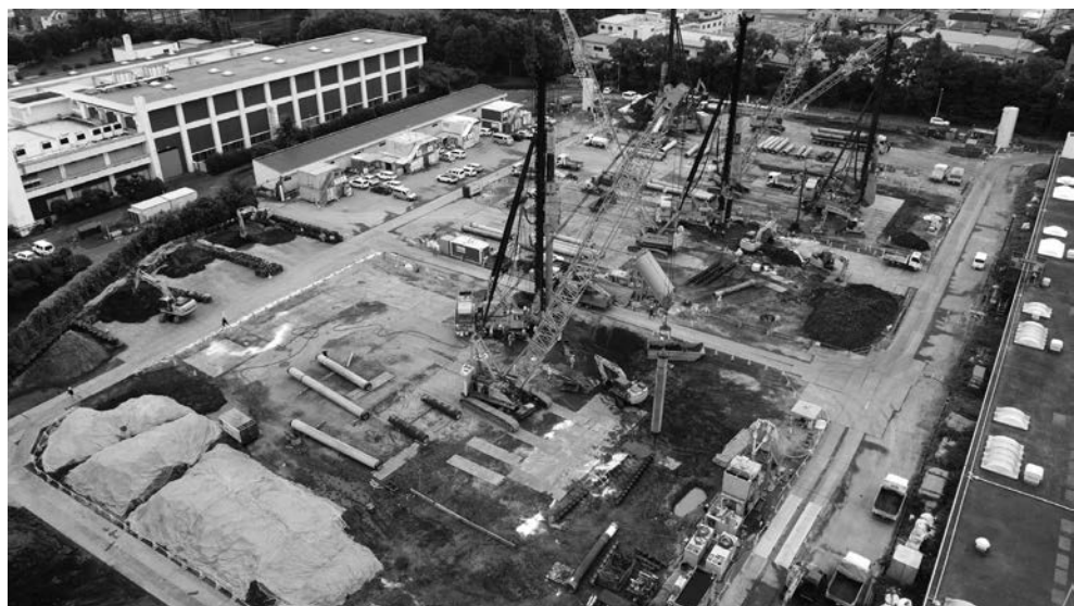
寺子屋のあった場所に沈砂池・ポンプ棟・管理棟を再構築している様子
