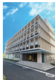
写真：日本下水道事業団研修センター新寮室棟
