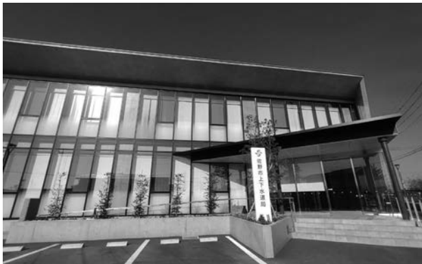
R4.12に完成した新上下水道局庁舎。 R5.1より新庁舎にて業務にあたっています。
