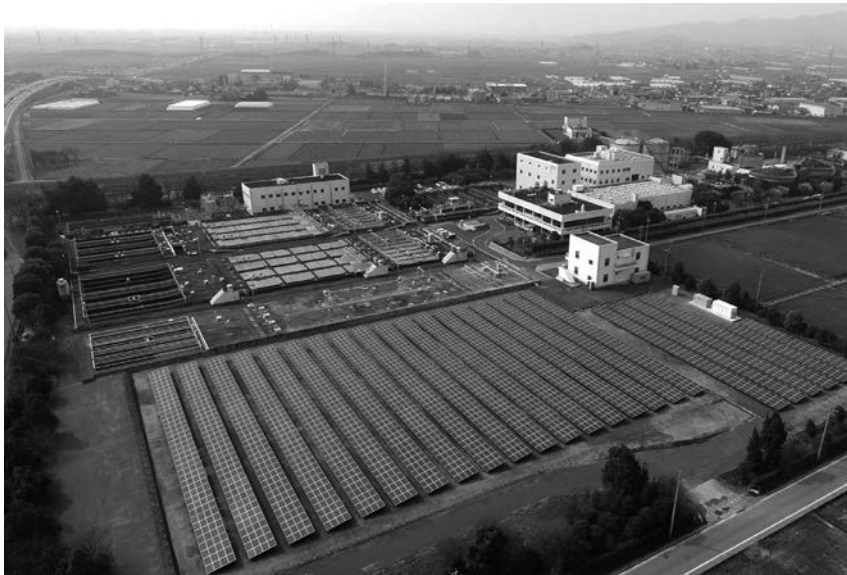
佐野市水処理センター（栃木県佐野市植下町3300） S51より通水開始 佐野市全域の汚水を処理しています。
