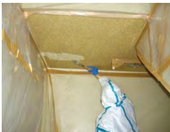
2-1 石綿含有パーライト吹付け除去（防護服着用）
