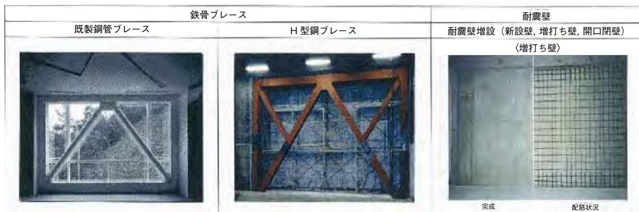
図－2 主な耐震補強法
