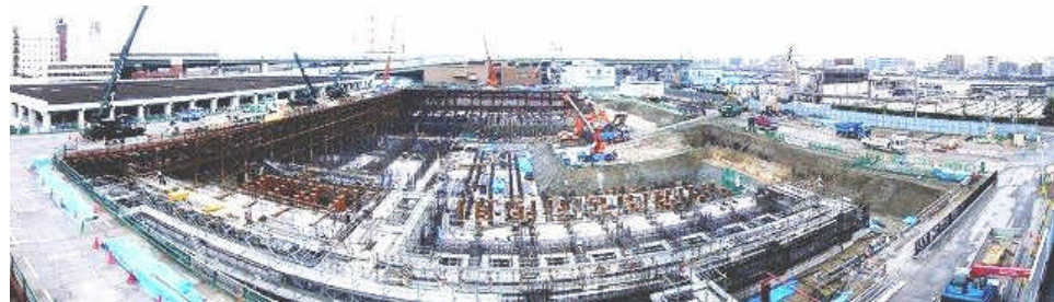
建設中の新水処理施設 (凝集剤添加担体ステップ流入式多段硝化脱窒法) 正面に湾岸線を臨む
