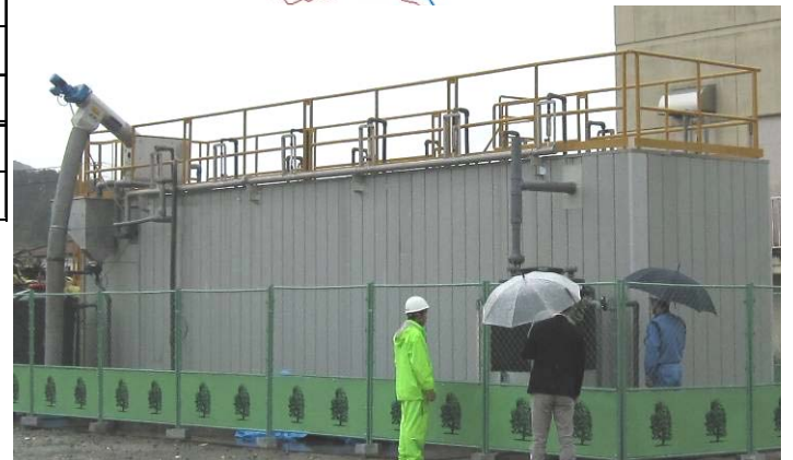
気仙沼市 仮設処理施設を設置しました。
