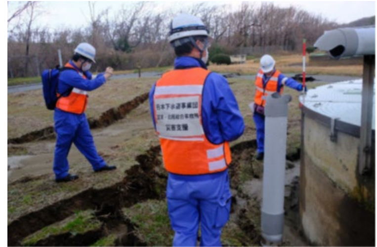
JS先遣隊による被災状況調査 (1月6日 羽咋浄化センター) 公式HPより
