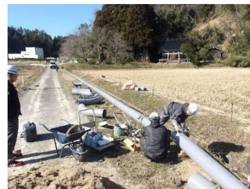
熊谷污水中継ポンプ場から珠洲市浄化センターまでの仮設圧送管の布設 (国土交通省HP 災害・防災情報より)
