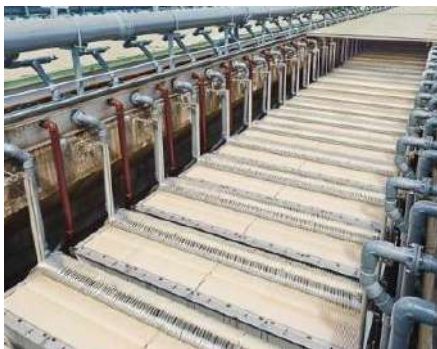
汚泥脱水施設の汚泥処分コストの縮減のため、流入下水から回収した繊維状物を脱水助剤として用いる新技術の導入を提案
