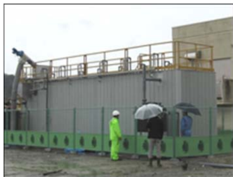
仮設処理施設の設置
