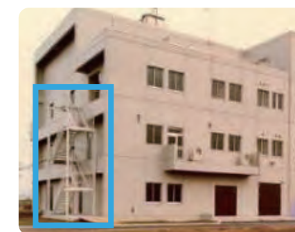
津波対策の例（屋外階段の設置）
