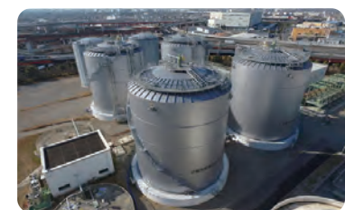
鋼板製消化タンク
