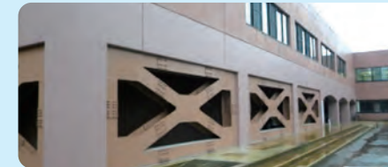
耐震工事（耐震鉄骨ブレース補強）
