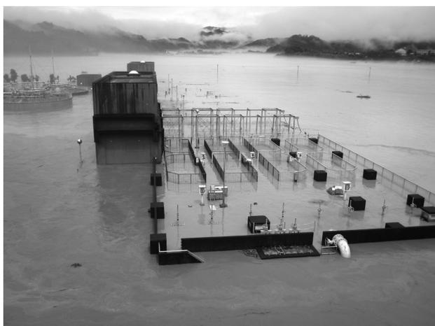
写真1：浸水状況(人吉浄水苑)
