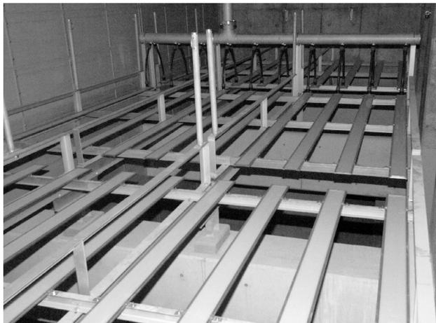
写真1 低圧損メンブレン式散気装置
