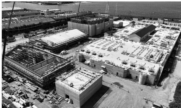
写真3 丸亀市浄化センター建設状況
