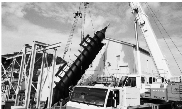
写真1 日比ポンプ場建設状況
