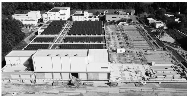
写真2 東広島浄化センター建設状況
