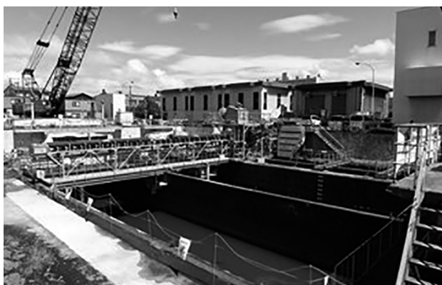
写真2 スクリーン設置工事状況
