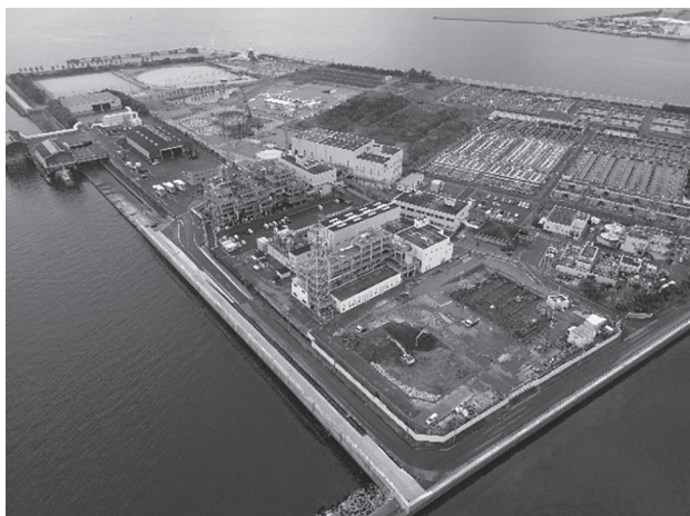
写真1 兵庫東流域下水汚泥広域処理場工事状況
