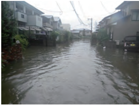
熊本地震による地盤沈下により浸水被害が発生
