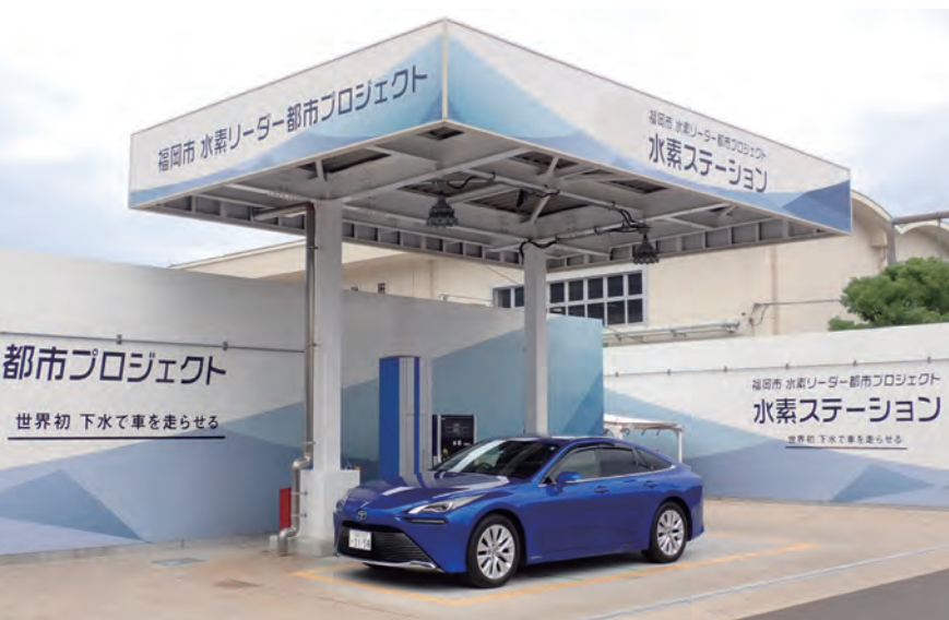
水素ステーション
