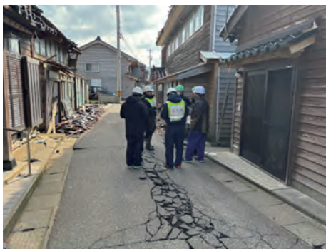
石川県輪島市にて住宅被害認定調査
