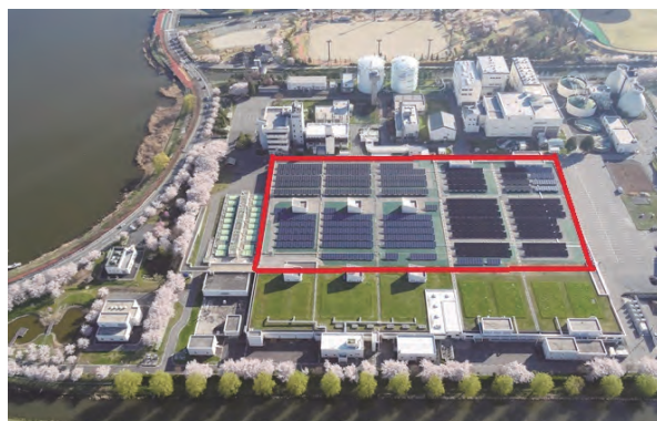
図4 諏訪湖流域下水道の太陽光発電設備
