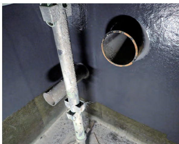
図4 受入槽内部状況
