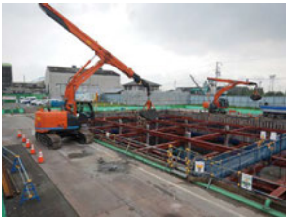
写真-2 掘削時における作業性の向上
