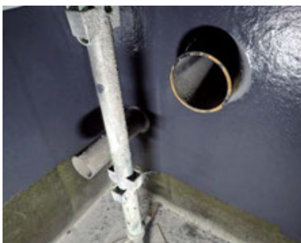
図4 受入槽内部状況
