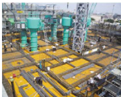
(土木躯体築造状況)
