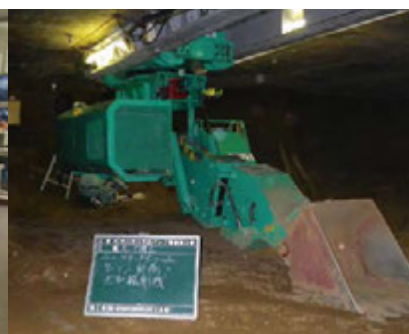
(函内掘削状況 中央監視室 (左) と掘削機 (右))
