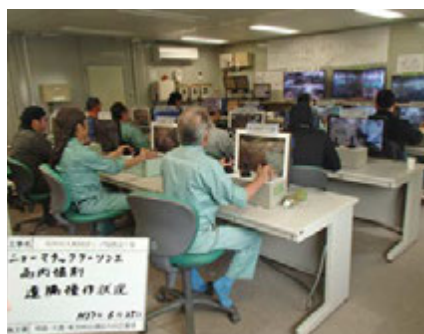
(函内掘削状況 中央監視室 (左) と掘削機 (右))
