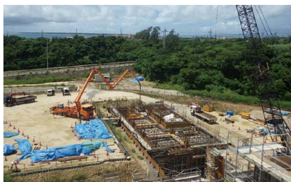
写真-5 し尿受入棟
