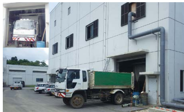
写真-2 脱水汚泥の場外搬出
