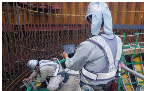
写真-6 タブレット PC による段階確認
