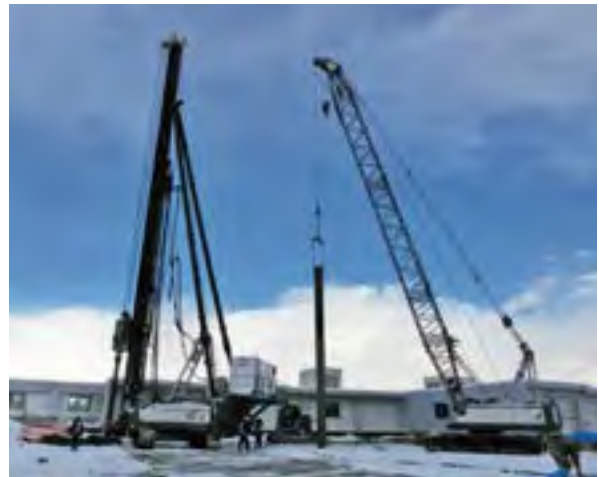
写真-2 工事風景
