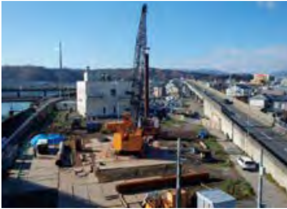
図6 施工状況全景
