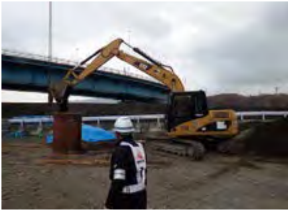
図7 砂を埋戻し用バケツに投入
