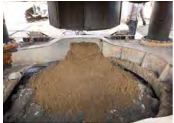
図9 埋戻し完了
