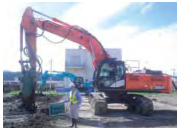
図5 パワーブレンダー施工状況
