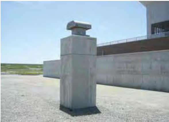
換気口の高上げ
