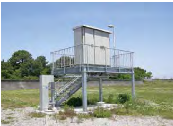
揚水ポンプ操作盤の高所移設
