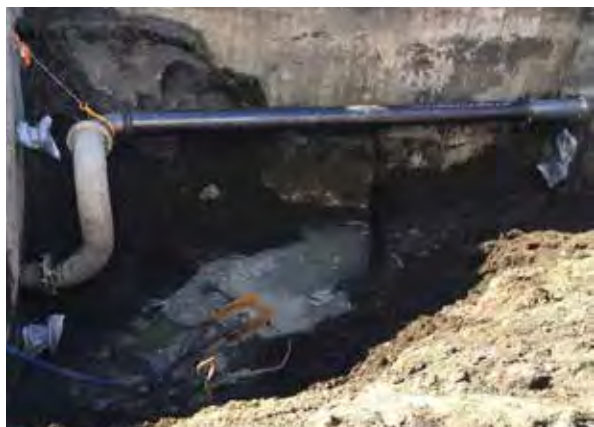
写真8 鷗川終末処理場 送水管応急仮工事
