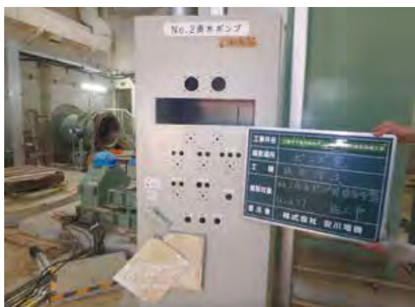
図7 応急本工事写真（現場盤被災部品の撤去）
