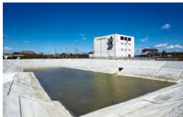
金田西雨水ポンプ場
