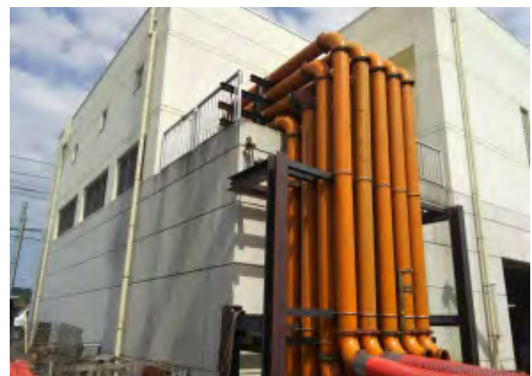
写真5 三原市下北方雨水ポンプ場 仮設ポンプ及び配管設置
