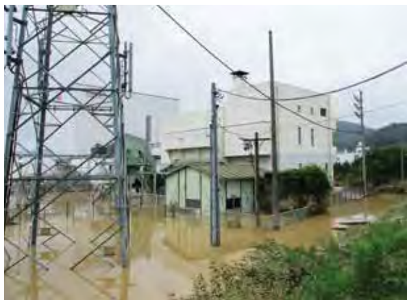
図5 被災状況写真
