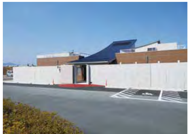
管理棟周辺防護壁
