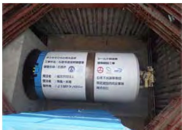
写真-3 シールドマシン投入組立完了
