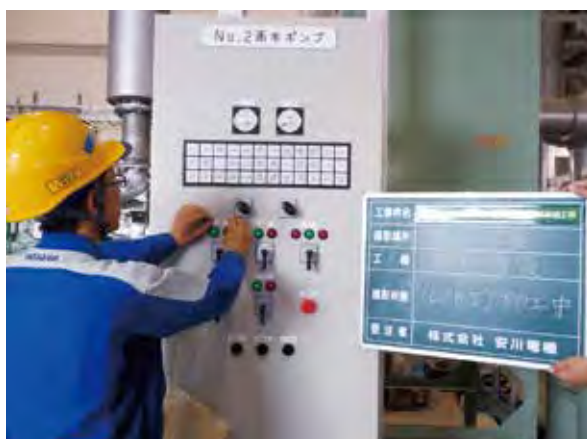
図8 応急本工事写真（現場盤新規部品の取付）
