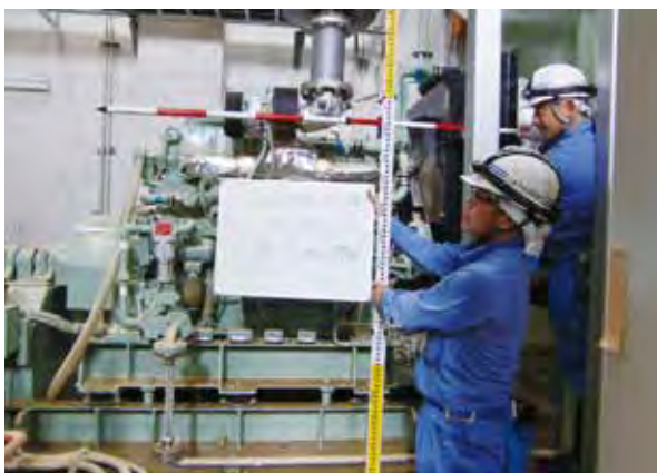
写真4 三原市下北方雨水ポンプ場 ポンプ機器状況調査
