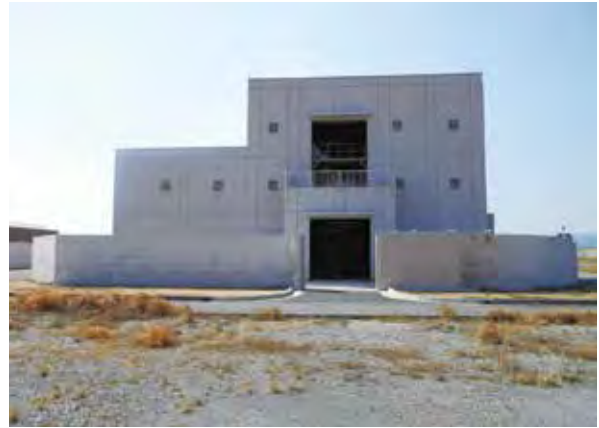
送風機棟周辺防護壁
