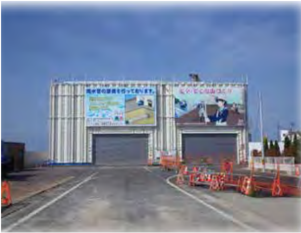
写真-1 防音ハウス設置完了
