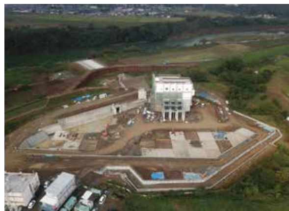
建設中の段畑雨水ポンプ場（上空より）
