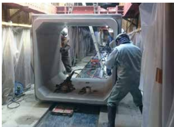
バイパス管内貯留工事施工状況
