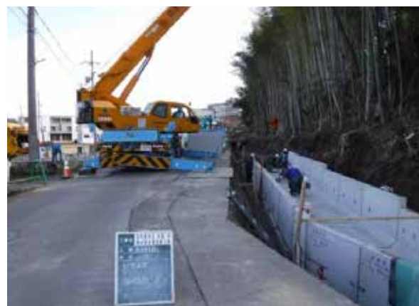
雨水排水路増強工事施工状況
