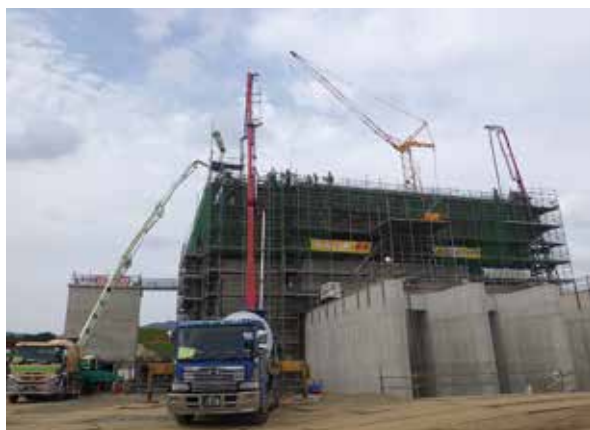
段畑雨水ポンプ場 3 階構築中
