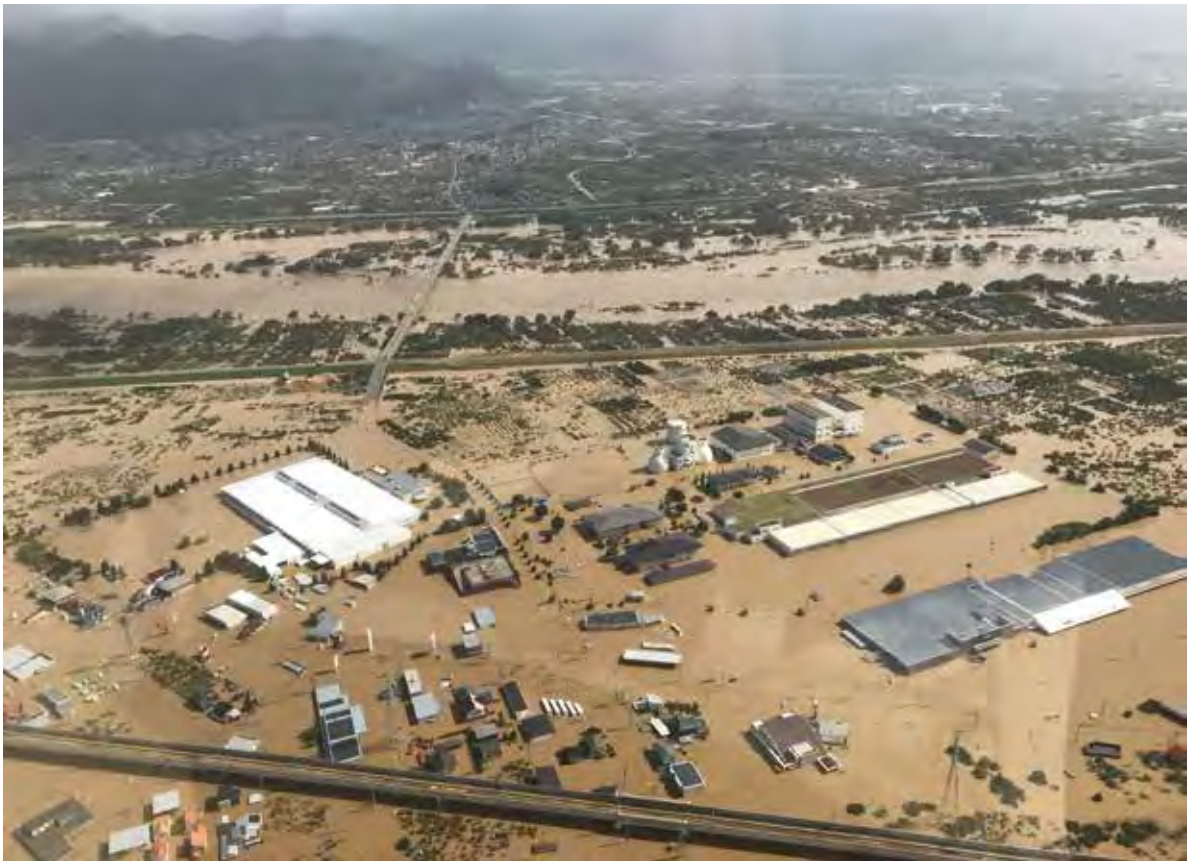
写真 1 クリーンピア千曲の被災状況 (長野県提供)
