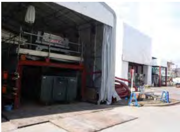
写真8 仮設脱水機の設置状況
