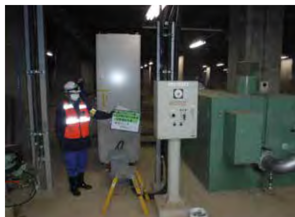
写真6 仮設送風機の設置状況
