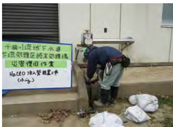
写真5 塩素注入管設置状況
