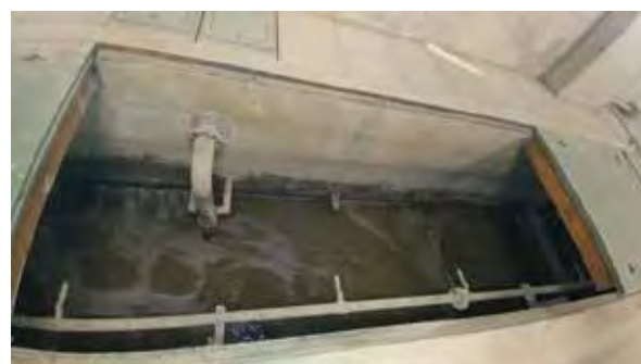
写真7 反応タンクばっ気状況
