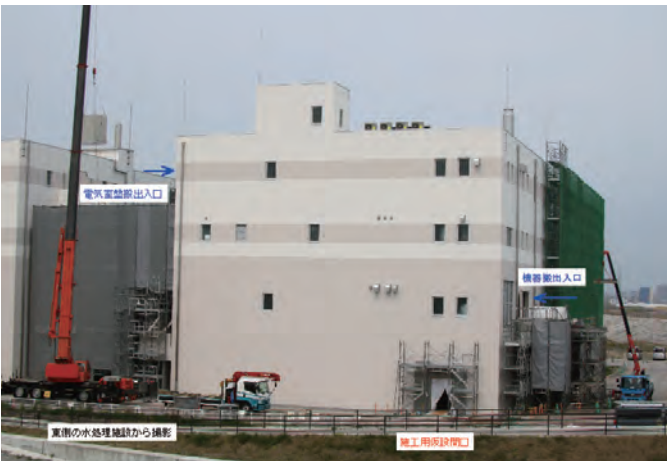
写真-3 電気設備工事の盤搬入と焼却設備工事の資材搬出状況盤搬入状況
