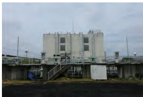
図1 k雨水ポンプ場外観
