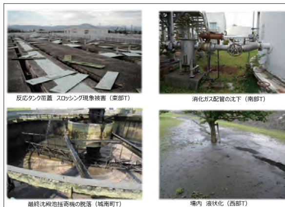
写真：処理場施設被災状況
