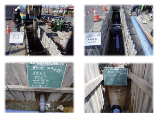
写真：災害復旧工事状況（布設替え）
