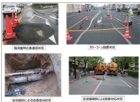
写真：応急復旧対応状況
