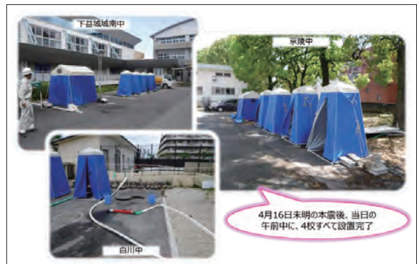
写真：マンホールトイレ設置状況
