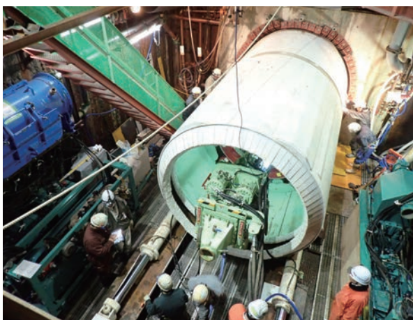
マシン地山貫入状況
