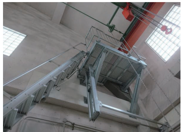
図 6 収納型タラップ（収納（上）階段利用（下））
