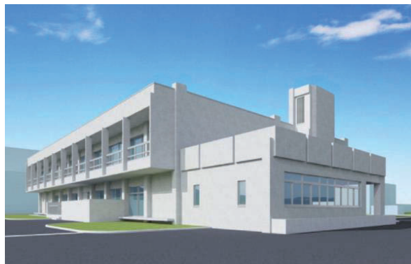
図3 管理棟耐震化対策後イメージ（減築）
