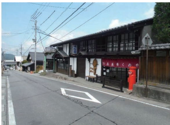
脇本陣を利用した宿と、奥は復元改修中の本陣
