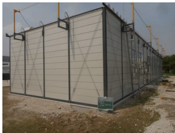
図1 代替新設（プレハブ）の設置例
