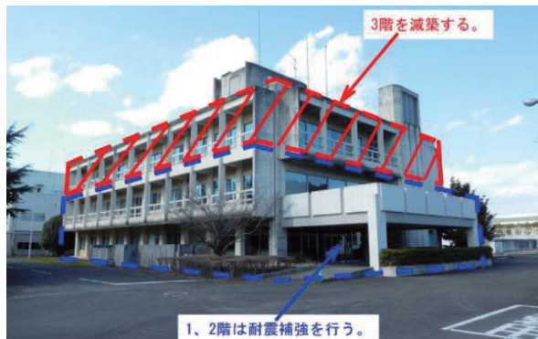
図2 管理棟耐震化対策前
