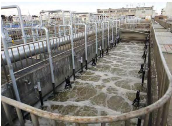
接触酸化法による暫定的な水処理施設
