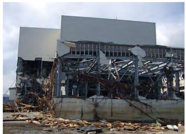
津波で側壁が破壊された汚泥炭化設備
