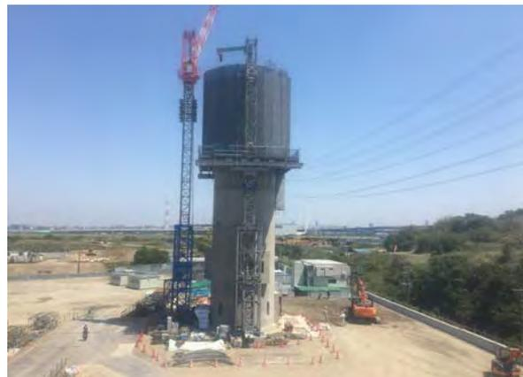
図8 ワークステーション工法による施工状況
