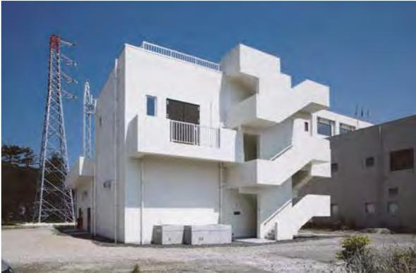
新築された特高受電棟では津波の高さ以上の階層に設備を設置
