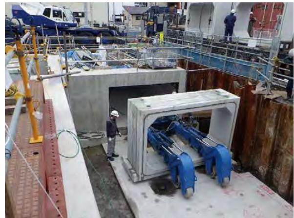
工期短縮事例2・流入渠・放流渠設置と建築工事の同時施工（吊り下ろし用のクレーンとリフトローラ工法の導入で建築工事と同時にボックスカルバートを施工）
