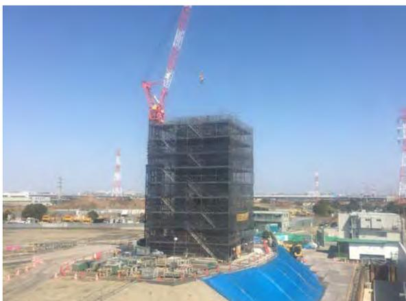
図5 焼却炉煙突の施工状況（第1～5段までの状況）
