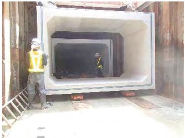
開削で施工が行われた岩沼市・二野倉排水路
