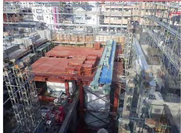
工期短縮事例1・建築工事とポンプ設備工事を同時施工
