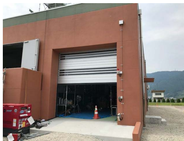
図8 高速シャッター（施工中）
