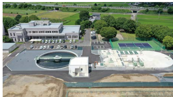
完成した水処理施設
