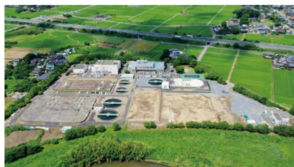
浄化センターともべ全景
