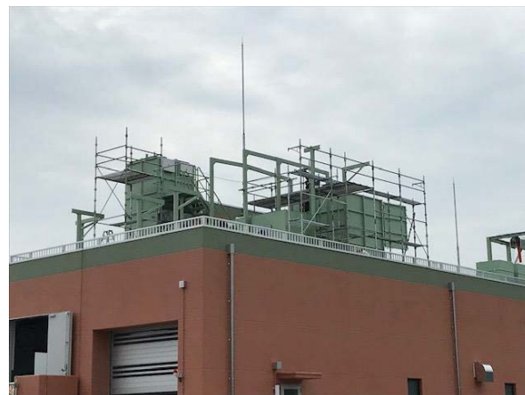
図7 脱臭装置全景（施工中）
