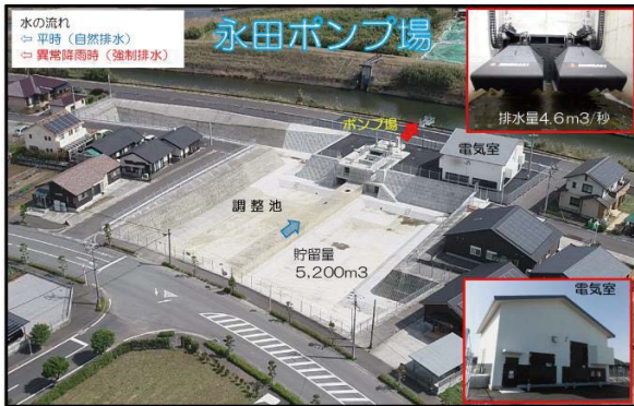
永田ポンプ場
