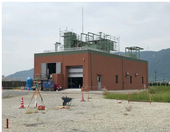
図9 現在のし尿受入施設（全景）
