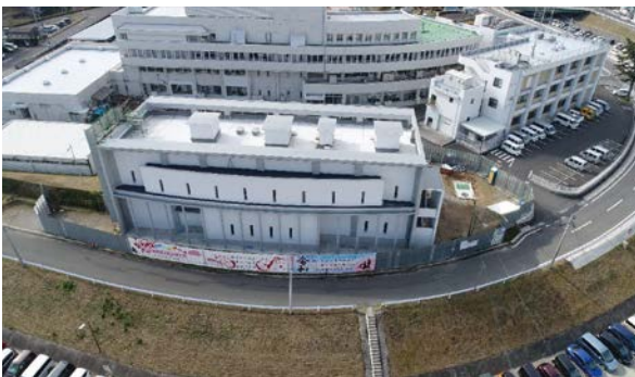
加世田浄化センター（手前）、市役所庁舎（奥）、 防災センター（右）
