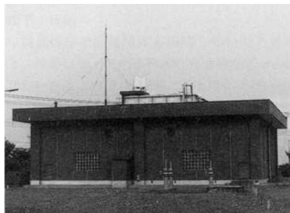
川越市月吉汚水中継ポンプ場
