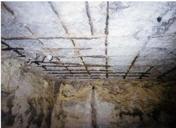
写真1 コンクリート腐食事例
