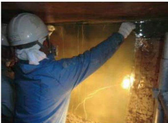
写真 4 シートライニング工法（光硬化型）の施工状況（シート貼り付け状況）
