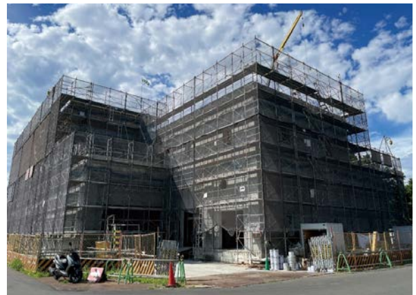
図 13 下水送水施設施工状況(令和 4 年 8 月末)
