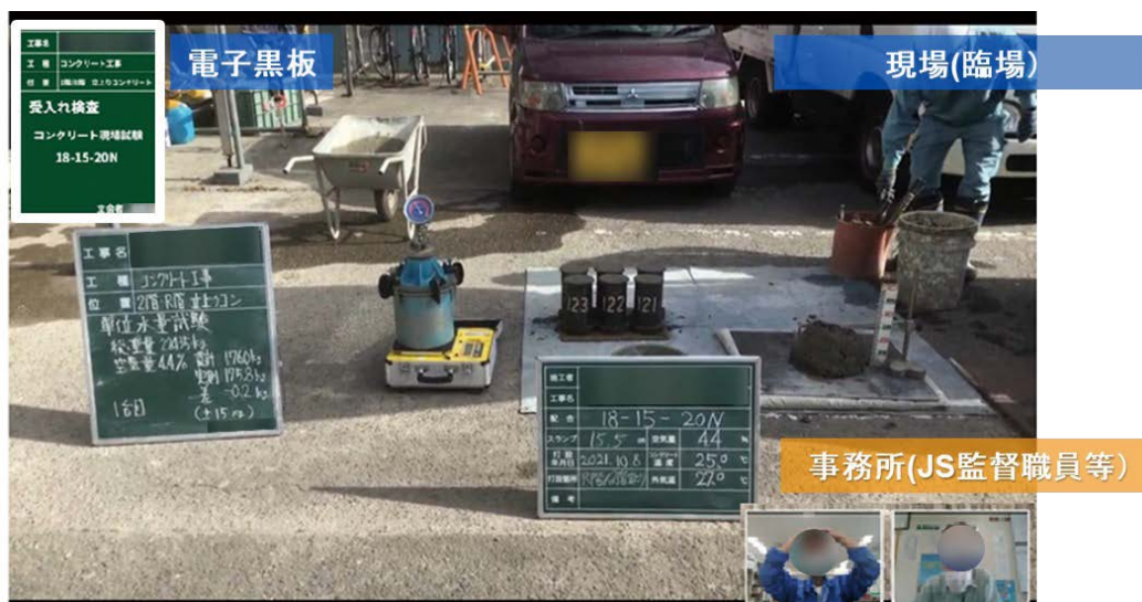
図 遠隔臨場における監督職員の PC 画面（コンクリート試験の例）
