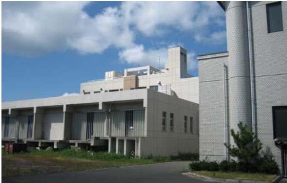
小浜浄化センター
