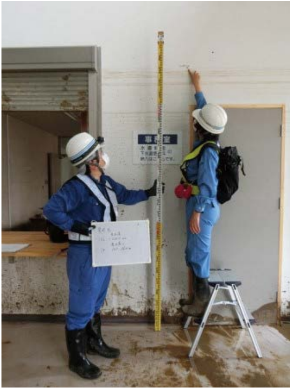
写真7：人吉市人吉浄水苑の被災状況調査
