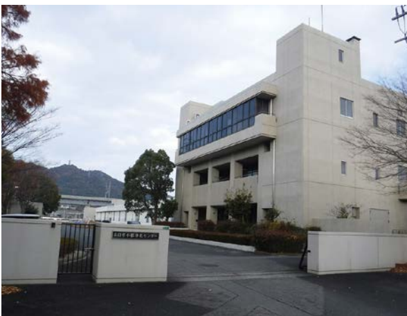
図5 小郡浄化センター外観
