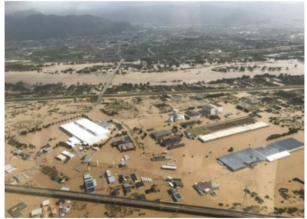
写真3：千曲川流域下水道下流処理区終末処理場周辺の浸水状況
