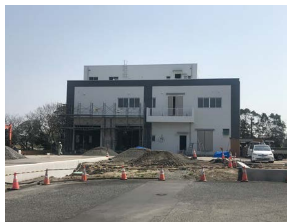
写真7 佐賀市衛生センターし尿受入施設
