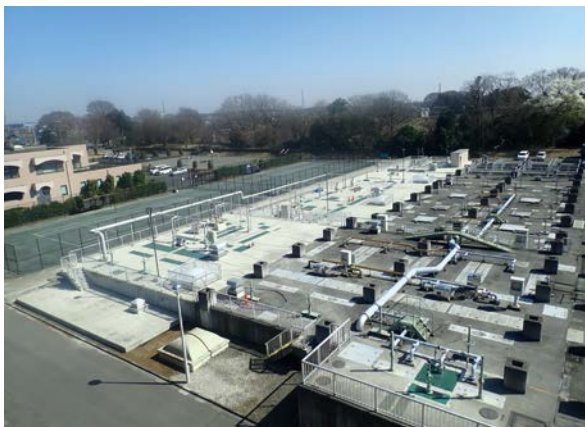
思川浄化センター水処理施設増設（全景）
