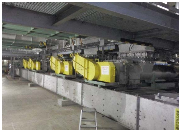
汚泥焼却設備更新（汚泥搬送コンベヤ）
