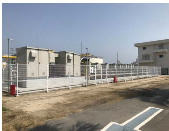
写真5 消化ガス発電設備増設
