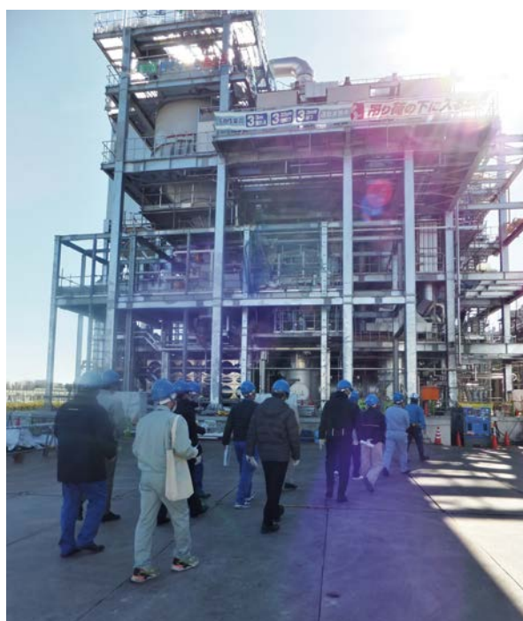
汚泥焼却炉の工事現場を見学
