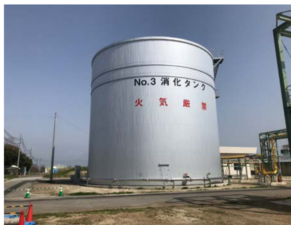
写真4 No.3 消化タンク増設
