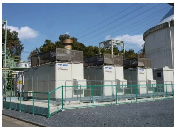
消化ガス発電（燃料電池方式）
