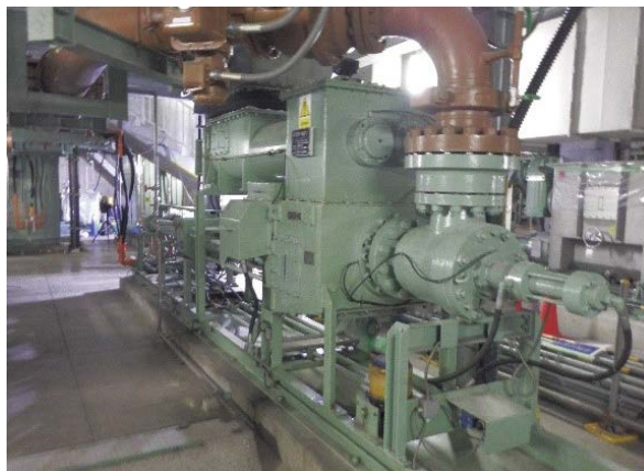
汚泥焼却設備更新（汚泥移送ポンプ）
