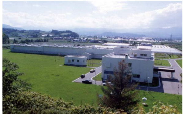
余市下水処理場
