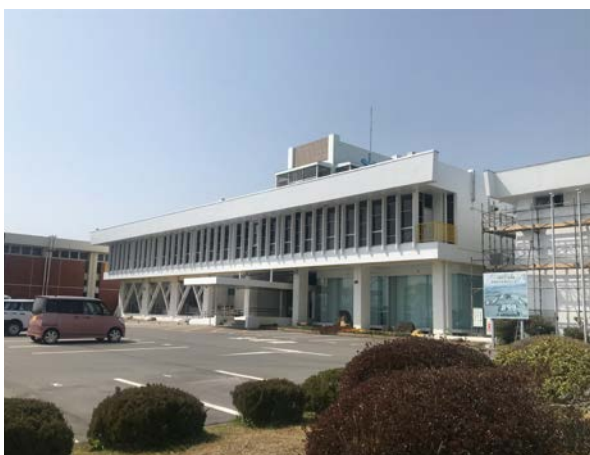
写真2 佐賀市下水浄化センター管理棟
