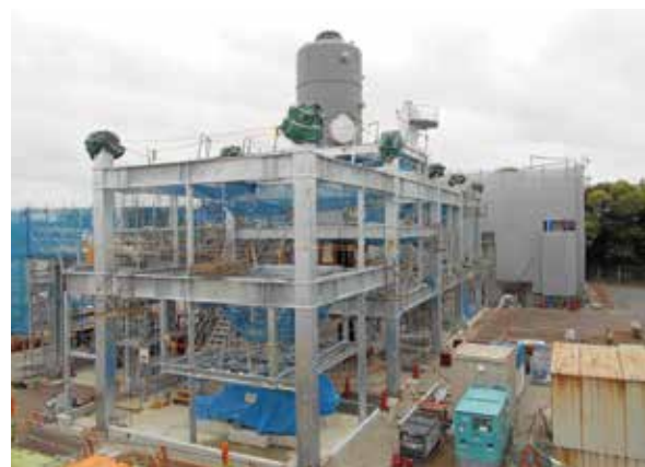
改築途中の中部 STP 汚泥焼却炉棟の写真
