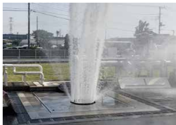
マンホールの浮上実習の様子
