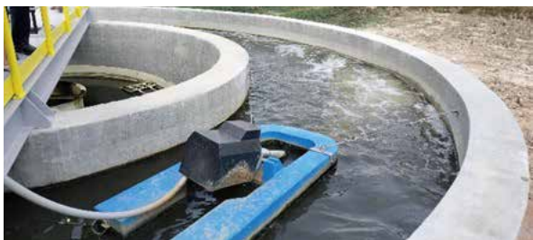
写真 3 POD コンセプト実証施設
