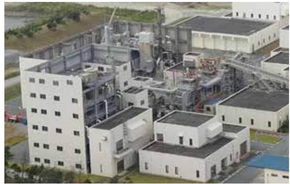
R5以降に改築予定の西遠STP汚泥焼却関連箇所の写真
