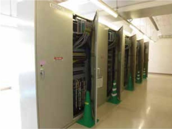
写真8 補助継電器盤
