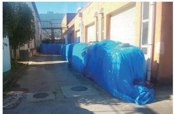
写真5 大型土嚢による対策
