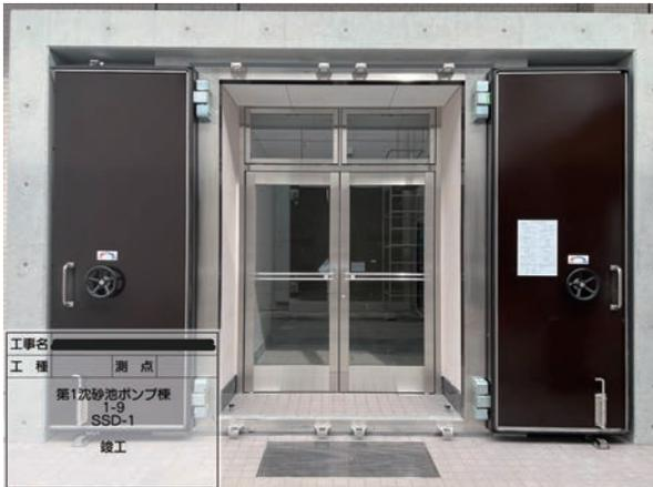
写真9 沈砂池ポンプ棟の出入り口に防水扉を設置
