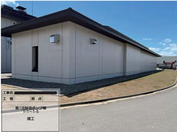
写真8 沈砂池ポンプ棟の窓を閉塞
