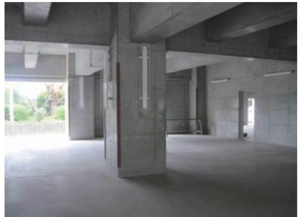
写真4 ピロティ構造
