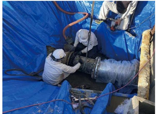
能登町新港中継ポンプセンター仮配管設置作業の様子
