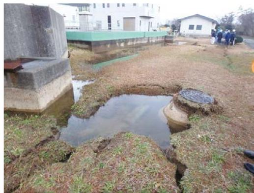
地盤沈下による場内埋設管の破損などが多数発生（羽咋市羽咋浄化センター）
