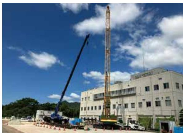
写真8 鋼矢板圧入施工状況
