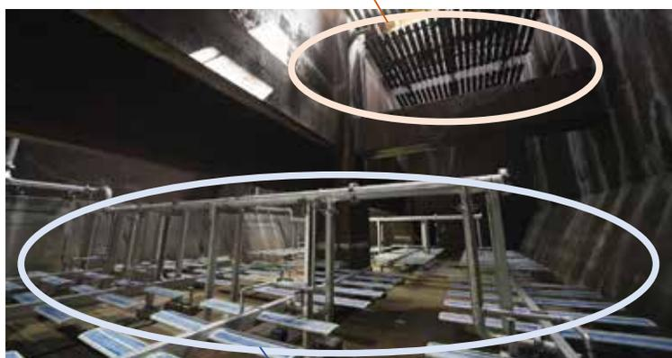
本研究で設置した散気装置
