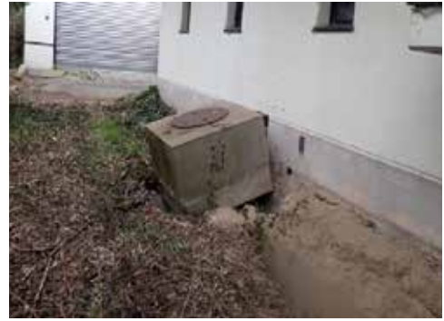
写真5 ハンドホールの傾斜脱落
