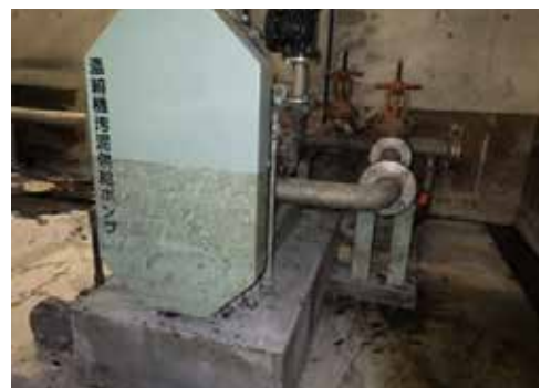
写真8 汚泥ポンプ室の水没
