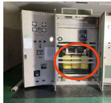
写真6 変圧器の破損
