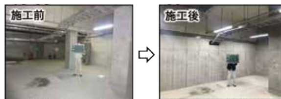
水処理センターの地震対策（耐震壁増設）
