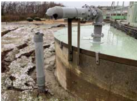
写真2 脱臭配管の破損
