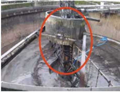
写真1 終沈汚泥掻き機ウィンドウエルの傾斜
