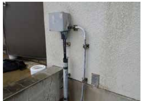
写真7 地盤沈下・電線管沈下によるケーブル露出
