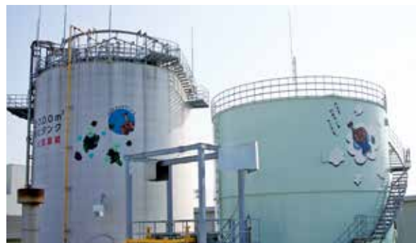
創エネにつなげる汚泥消化システム：鋼板製消化タンク（左側）と消化ガスホルダ（右側）
