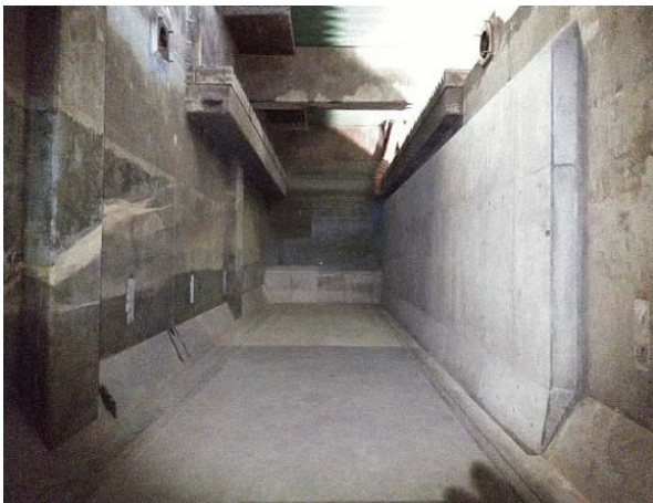
写真8 既設設備の撤去後の耐震補強
