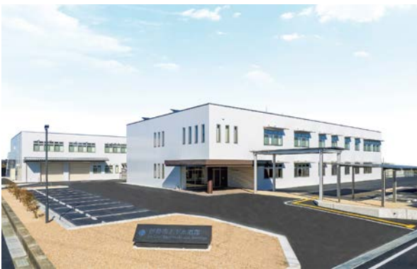
上下水道部新庁舎
