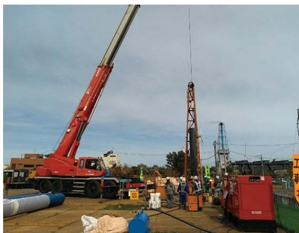
写真2 スーパーウェルポイント工法の施工
