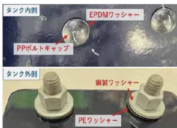
図2 ボルト締結部材
