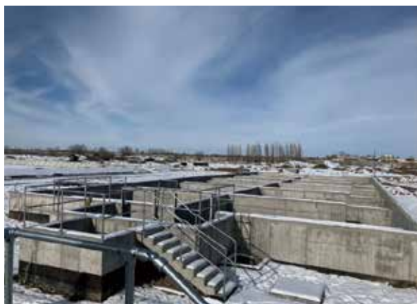
写真4 建替中の消毒槽
