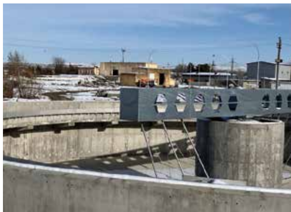
写真3 建替中の沈殿池（奥に老朽化した既設処理場が見える）
