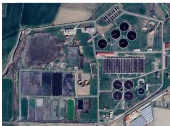
写真5 サマルカンド市の処理場（写真左側に汚泥を貯留する施設が見える）
