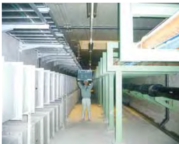
写真-4 伸縮継手が設置された管廊（臭気ダクト、配管、電気ケーブルを移設しながら施工）
