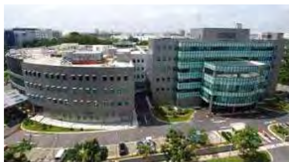
図－3 Water Hub (出典：PUB ホームページ)
