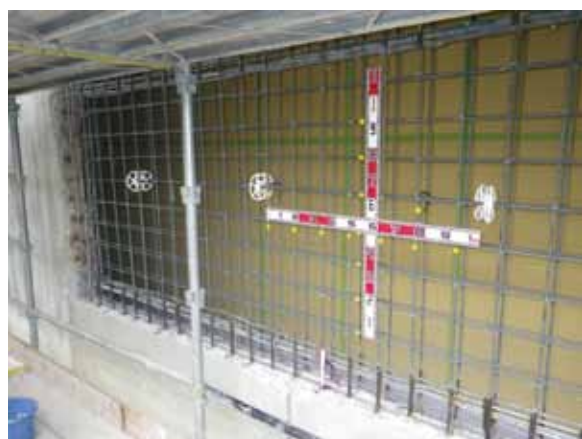
写真-2 管理棟施工状況（開口部の閉塞）
