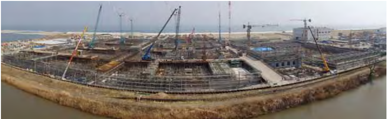
写真－２ 新水処理施設築造状況
