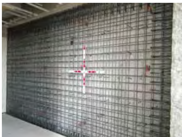
写真-1 管理棟施工状況（既設壁の打増し）
