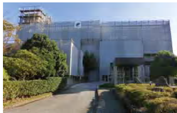
写真-3 管理棟外部足場設置状況
