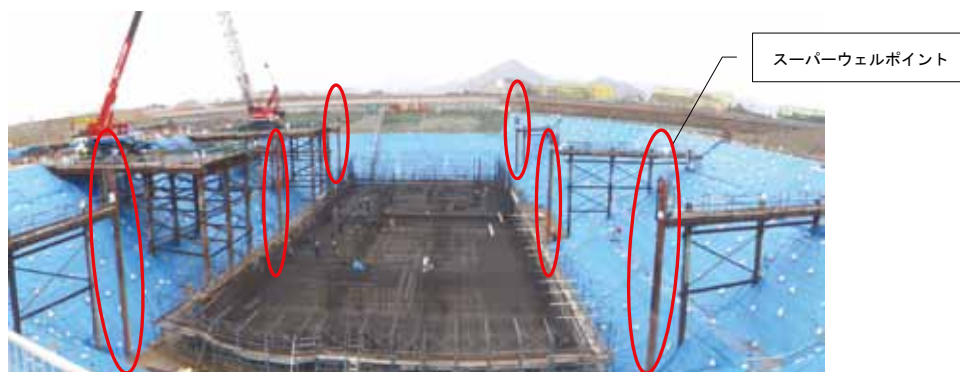
写真－２ スーパーウェルポイント設置状況（急速ろ過棟）
