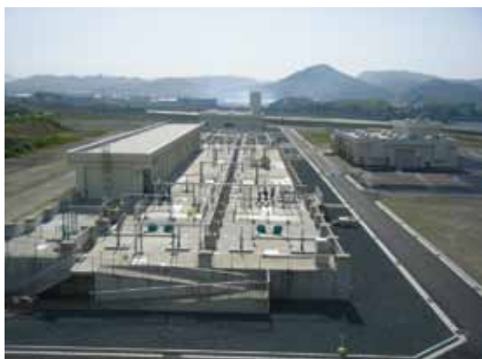
写真－１ 水処理棟・急速ろ過棟・汚泥濃縮棟 (流入ポンプ棟より撮影)
