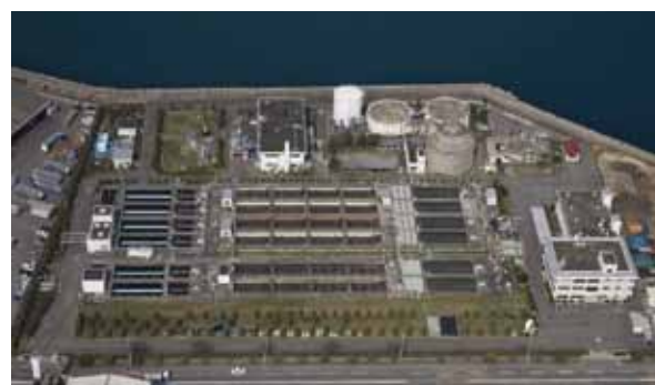
今治市下水浄化センター（分流一部合流）
