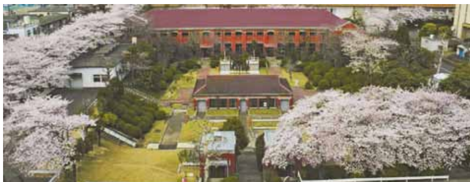
写真－１ 旧三河島污水処分場（ポンプ場）
