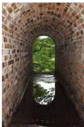
写真－３ 仙台市煉瓦下水道
