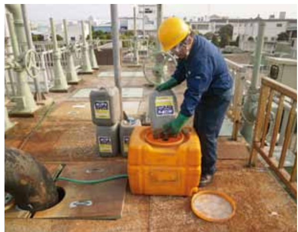
実験風景 鉄材投入試験
