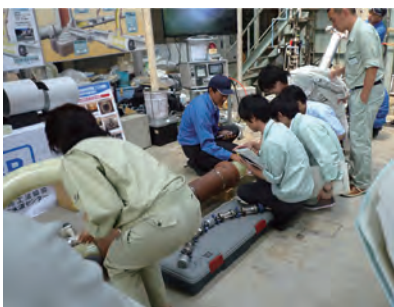
管更生工法のデモ風景
