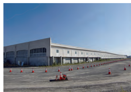
水処理上屋（西系6系列目）の252 mの桁行
