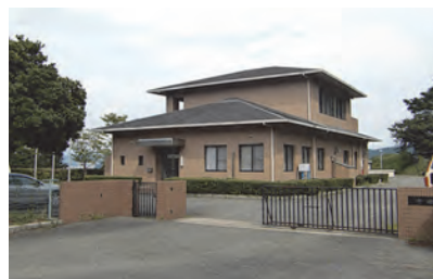
正門から管理汚泥処理棟へのアプローチ
