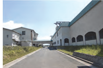
水処理棟（右）と汚泥処理棟を結ぶ地上式管廊
