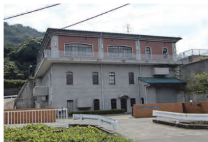
ポンプ棟（上部は管理棟）のファサード
