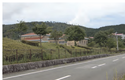
前面道路から築山と建物の眺望
