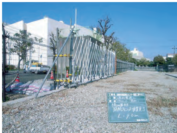
【写真6：仮設出入口設置状況】
