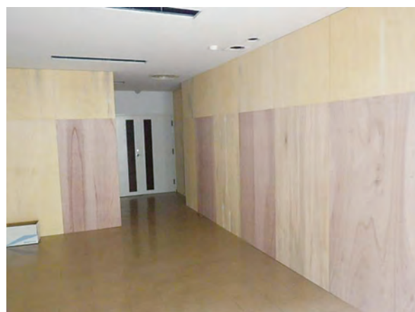
【写真4：間仕切り設置状況】
