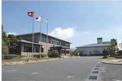
管理棟および沈砂池ポンプ棟のファサード
