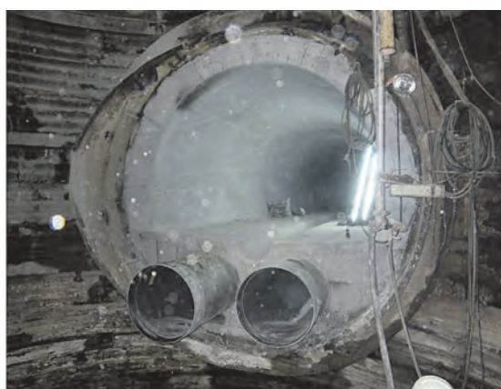
二次覆工の完了
