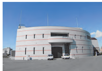
ポンプ場の円筒形ファサード
