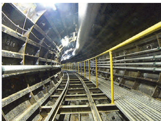
一次覆工の状況
