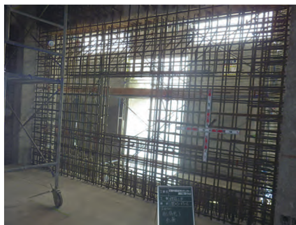
【写真5：耐震壁配筋状況】
