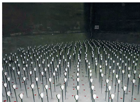
【写真2：せん断補強筋設置状況（白く見えるのが定着部、この後底盤を増打ちするので突出している）】
