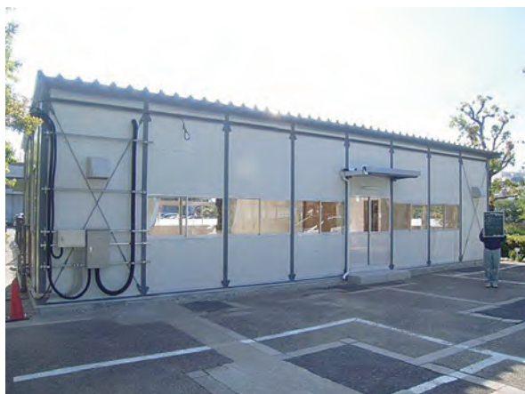
【写真3：仮設事務所設置状況】
