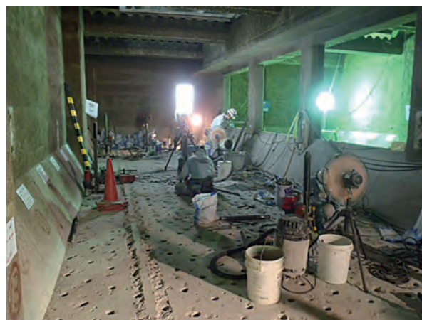
【写真1：底盤の削孔状況】
