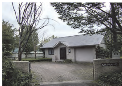
正門から管理棟へのアプローチ
