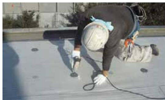
写真3 機械式固定法
