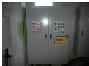
写真10 仮設制御盤設置
