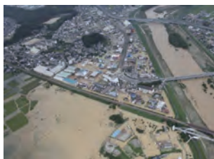
写真 3 市内の浸水状況
