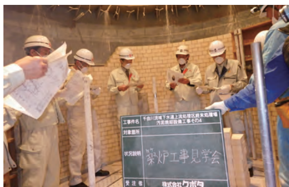
写真－5 炉内部視察中
