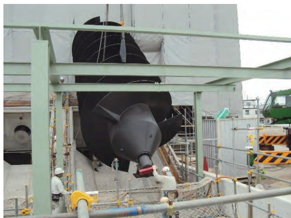
写真-5 直径3.4mの巨大なスクリュウ据付
