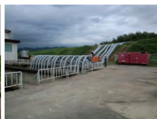
写真 8 仮設水中ポンプ 設置状況
