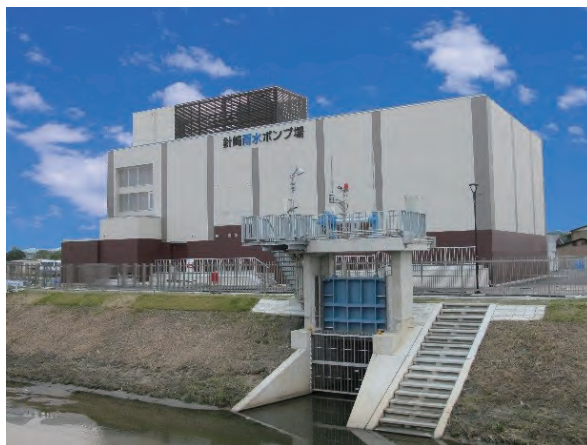
写真－4 針崎雨水ポンプ場
