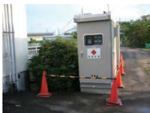
写真9 仮設電源盤設置
