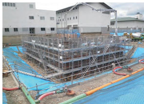
写真－3 2号焼却炉棟地下施工状況
