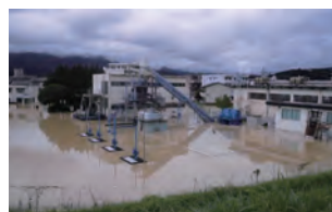
写真 5 ポンプ場被災状況 （和久市ポンプ場）
