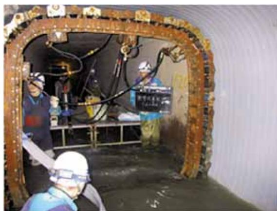
写真-6 管更生施工状況
