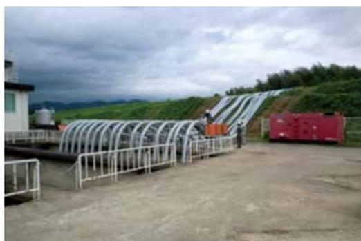
写真6 仮設水中ポンプ設置状況
