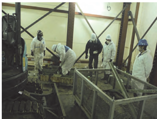
写真－２ 仮設乾燥施設建屋内の乾燥機の解体状況と放射線量の測定状況
