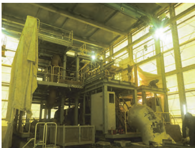
写真－２ 仮設乾燥施設建屋内の乾燥機の解体状況と放射線量の測定状況
