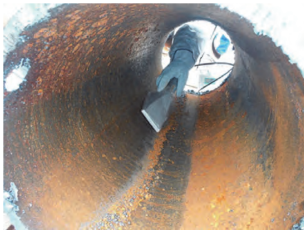
写真－１ 圧送配管の撤去及び放射線量の測定状況
