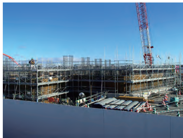
写真－7 工事全景(二野倉排水ポンプ場)
