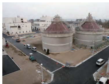
復旧した宮城県阿武隈川下流域下水道県南浄化センター（10万m 3 /日）
