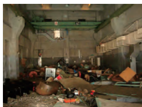
主ポンプモーター室
