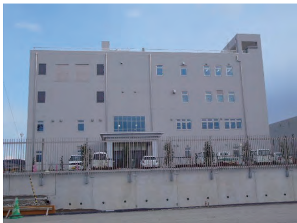
新管理棟 1F水質試験室 2F下水道課事務室 3・4F自家発電機・受変電設備室
