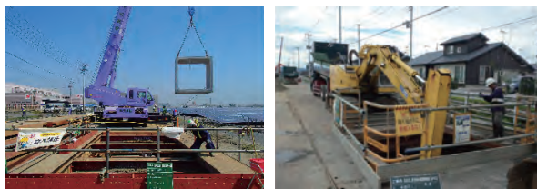
写真－6 ボックスカルバートを据付に80tラフタークレーンを使用、開口部養生
