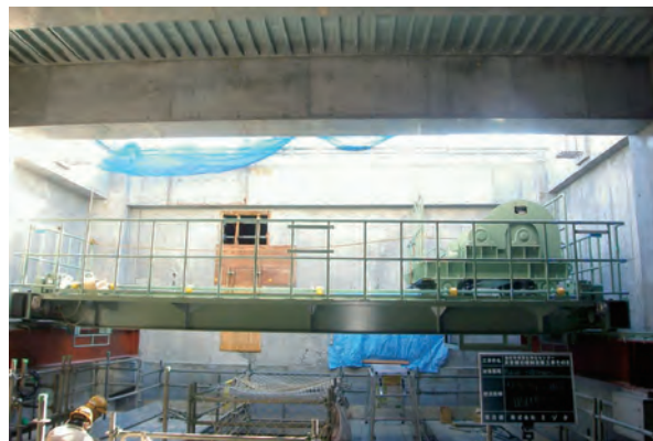
写真4 天井クレーンの搬入状況
