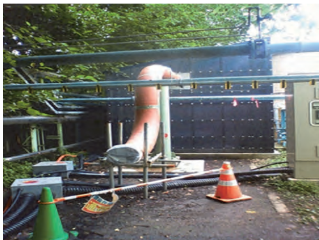
写真－１ 圧送配管の撤去及び放射線量の測定状況
