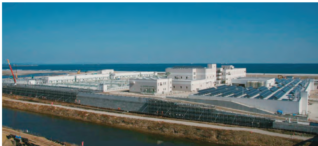
写真1 新水処理施設全景
