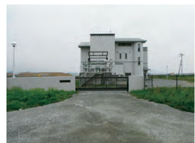
復旧した陸前高田市高田ポンプ場
