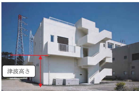
新築された特高受電棟
