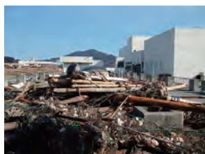
水処理棟上部のガレキ
