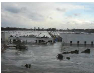
津波で水没する宮城県阿武隈川下流域下水道県南浄化センター
