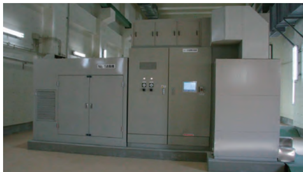
写真6 高速軸浮上式ターボブロワ
