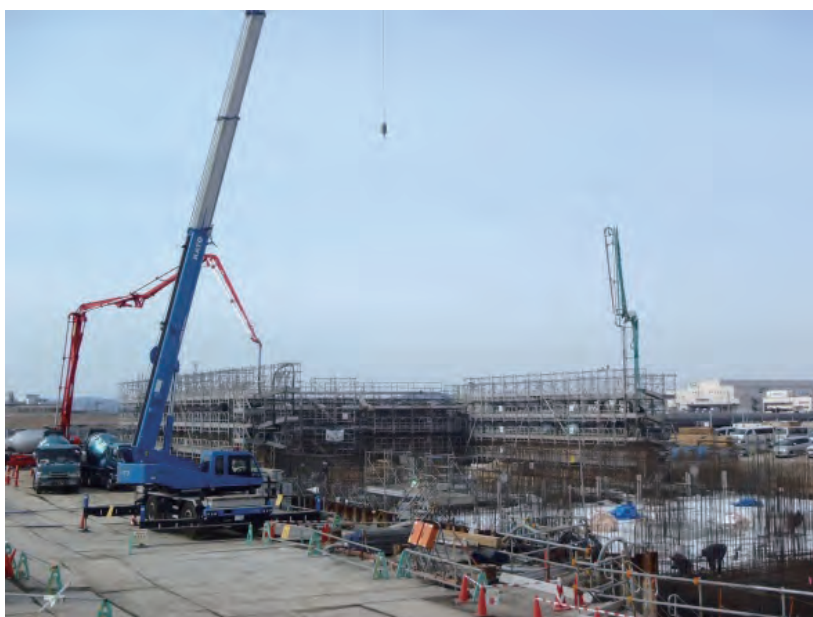
写真－8 工事全景(矢野目排水ポンプ場)
