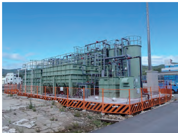
鹿折(浜町)仮設污水处理施設
