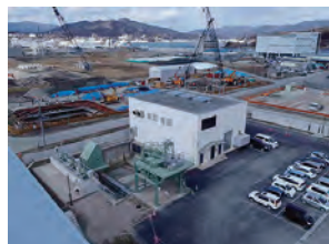
川口雨水ポンプ場
