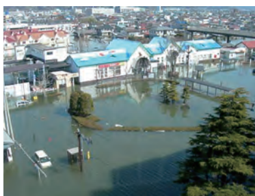
地盤沈下による浸水被害（石巻駅）
