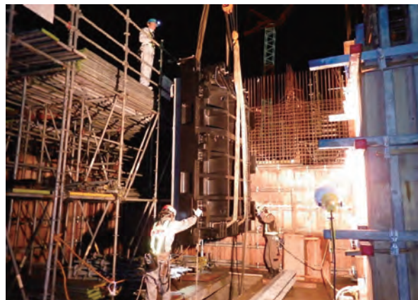
写真5 ゲートの据付状況
