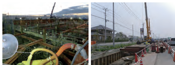
建設中の二野倉排水ポンプ場(左)と排水路(右)
