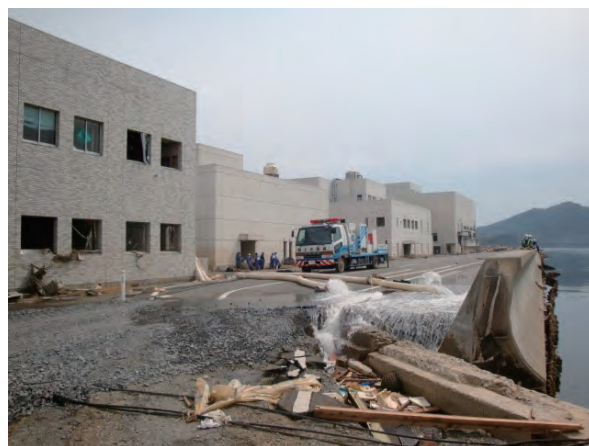
国交省排水車による排水状況
