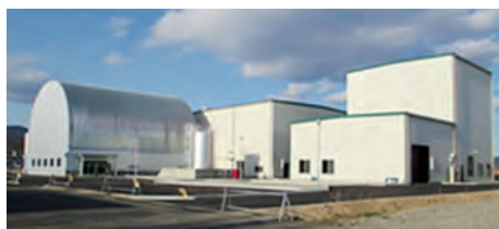
福島県阿武隈川上流域県北浄化センター汚泥乾燥施設
