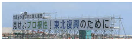
南蒲生浄化センター建設現場に掲げられたスローガン
