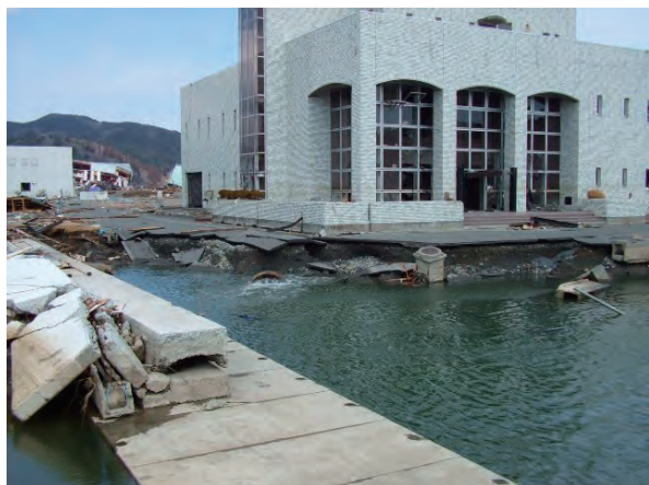
被災直後の管理棟前周辺
