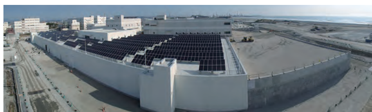
復旧工事中の南蒲生浄化センター全景
