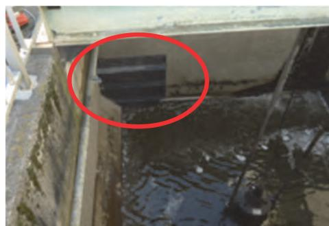
図10 反応タンクの隔壁閉塞状況
