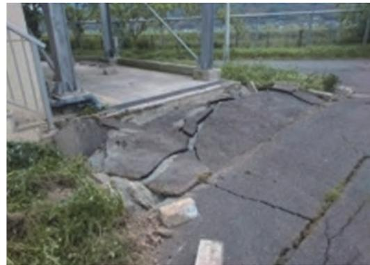
図8 地盤沈下の状況
