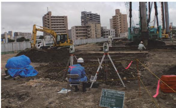
写真-5 先行削孔工パイルナビ管理
