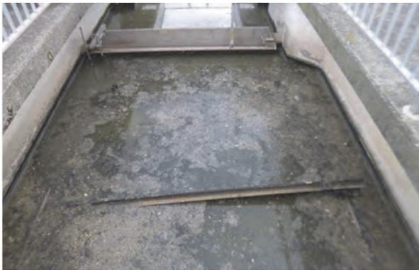
図7 最終沈殿池掻寄機の破損状況
