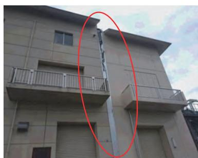
図4 汚泥処理棟継手部の破損状況
