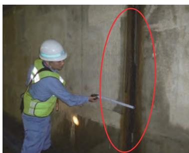
図5 水処理施設継手部の破損状況
