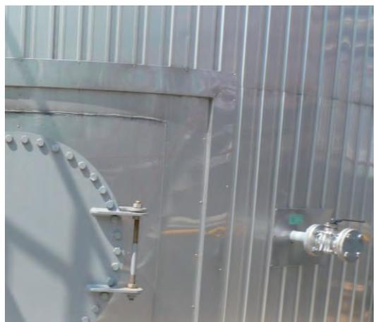
写真-3 保温材(上)とラギング施工(下)
