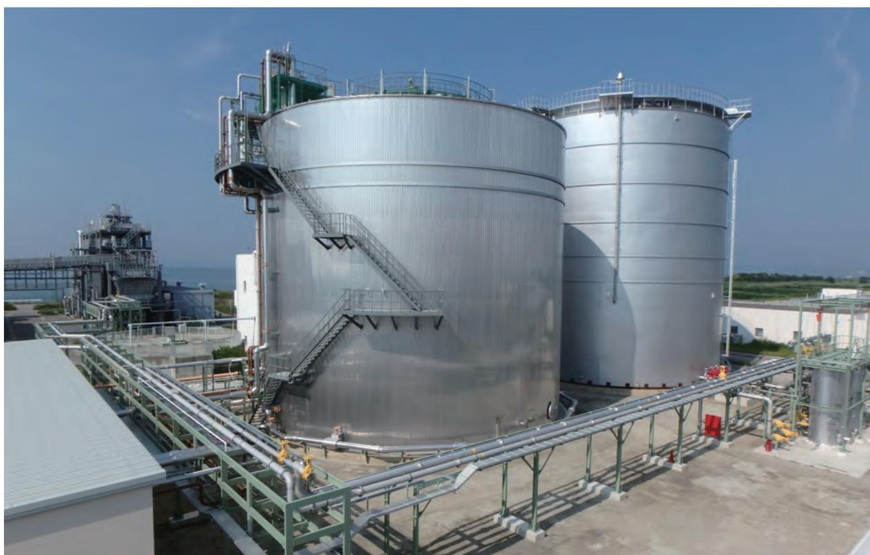
写真-1 鋼板製消化タンク(左) (右は低圧ガスタンク)
