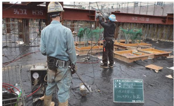
写真-6 ポンプ棟(土木)施工、油圧ジャッキによる土圧開放
